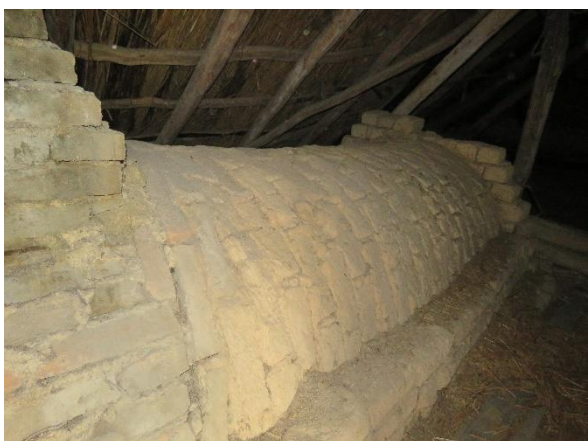
boltozott szabadkémény kürtője – kéményfejezet és nádfedés a nyugati oldalon
