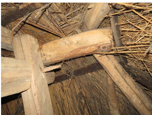
kontyolt vég állapota – kémény mögötti elkorhadt szarufa (mellette kiváltás)
