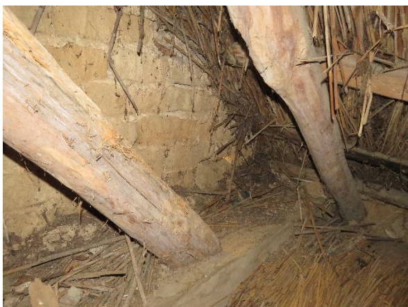
kötőgerenda – kémény melletti elkorhadt gerincszellemen és a kiváltó keret
