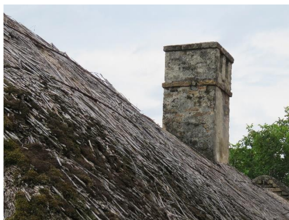
boltozott szabadkémény kürtője – kéményfejezet és nádfedés a nyugati oldalon
