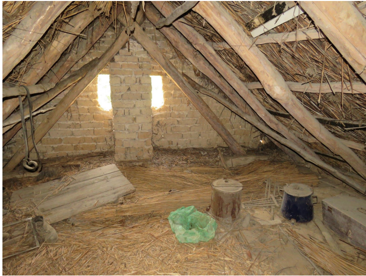
padlástér, ollóágas tetőszerkezet, vályogtégla oromfal
