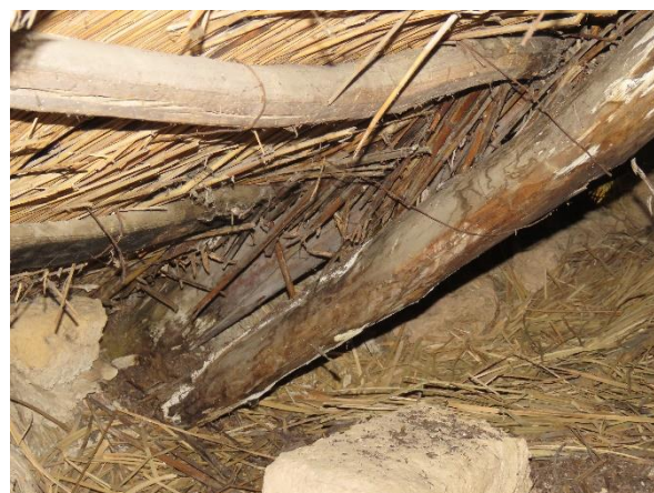
kontyolt vég állapota – kémény mögötti elkorhadt szarufa (mellette kiváltás)
