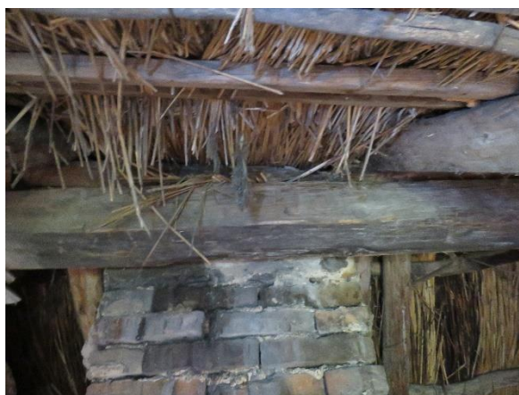
kötőgerenda – kémény melletti elkorhadt gerincszellemen és a kiváltó keret
