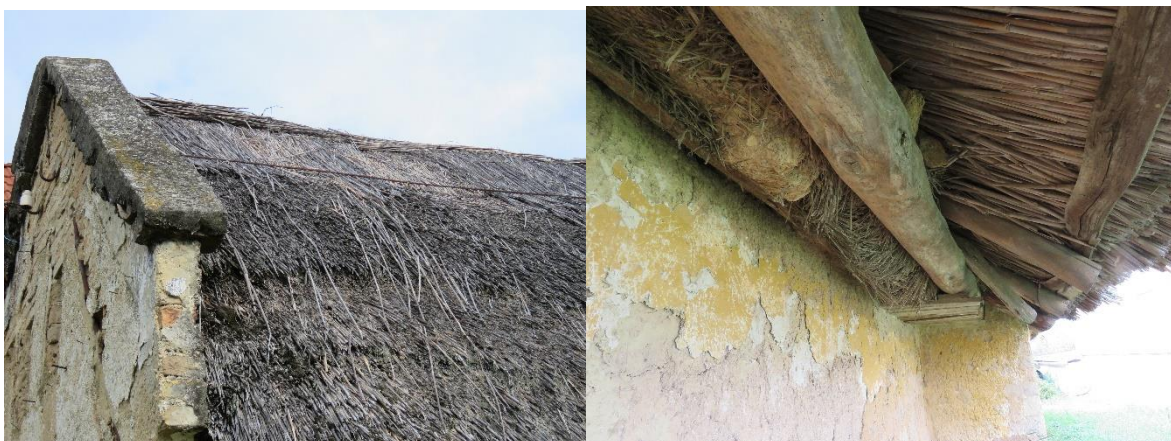
oromfal és nádfedés (keleti oldal) – ereszalja, szalmássár kitöltéssel
