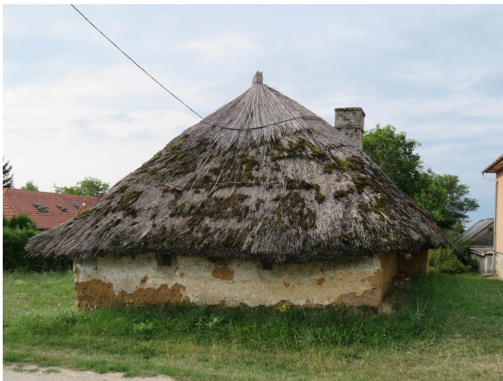
utca felőli homlokzat és épülettömeg
