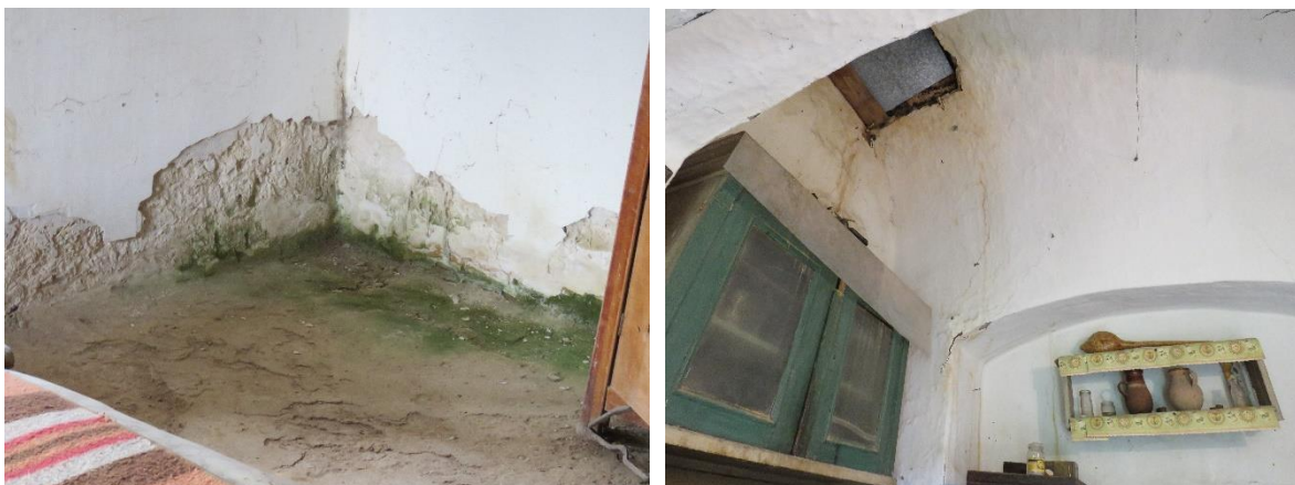
mohásodott falsarok (dél-nyugat), szabadkémény és vályogtéglaboltozat
