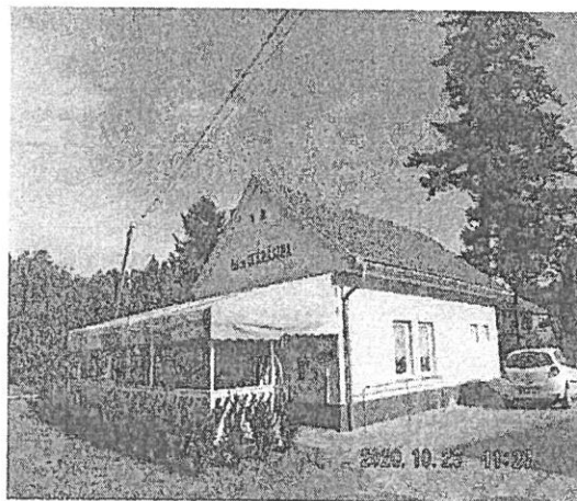
Rezi út felőli homlokzat
