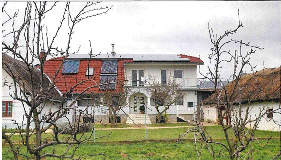
új lakóépület déli homlokzata
