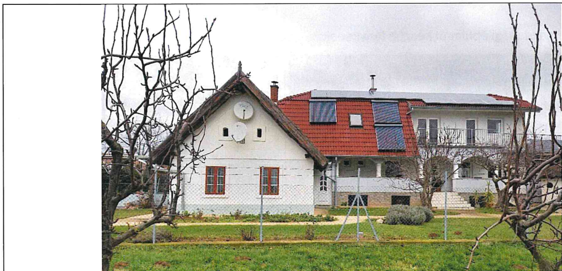
lakóépület déli homlokzata
