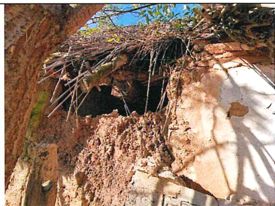
lyukas tető, mállott vályogfal
